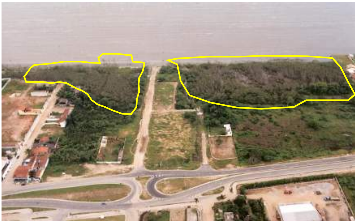
Figura 14. Fotografia aérea da Baía da Enseada, no ano de 2005. Fonte: Acervo Atlântica Consultoria.
